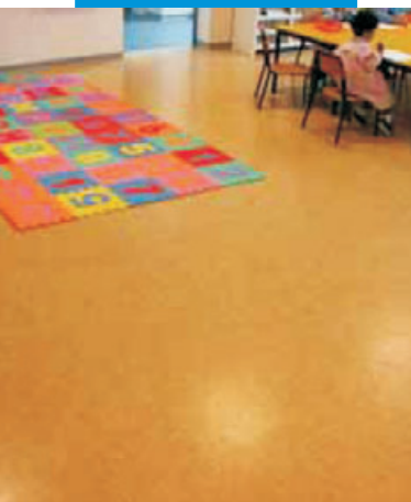
3. Linoleum položené na podklad vyrovnaný Ultraplanem Eco - mateřská škola Mirabello, Cantù (Como), Itálie
