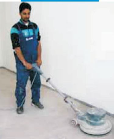
2. Broušení podkladu před nanesením Ultraplanu Eco - mateřská škola Mirabello, Cantù (Como), Itálie
